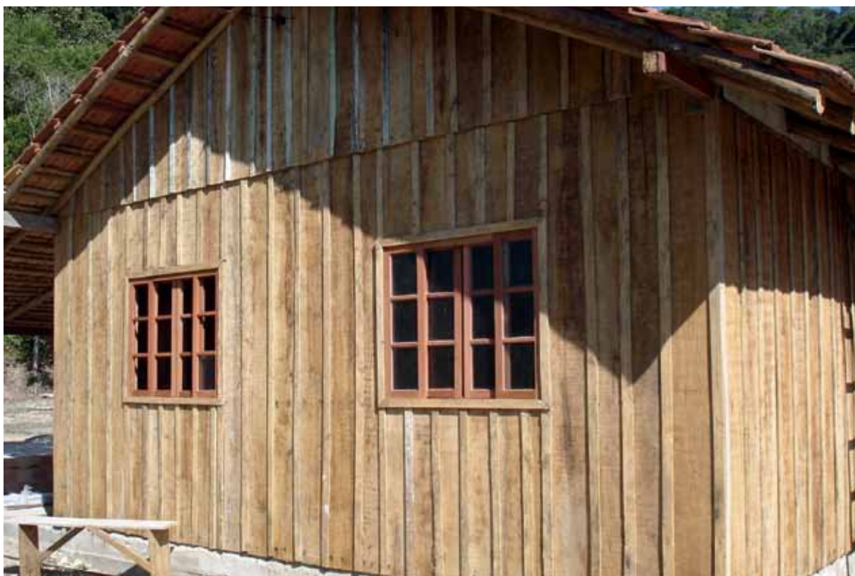
Figura 4 - Casa construída com madeira de Miconia cinnamomifolia . (Foto: Cristiano Schuch)
